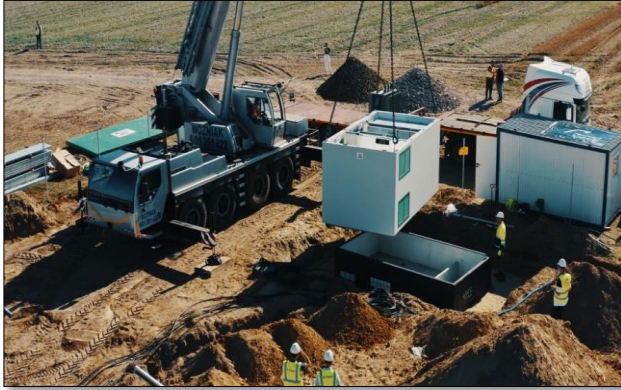
Zdjęcie 4 Stacja transformatorowa - montaż
