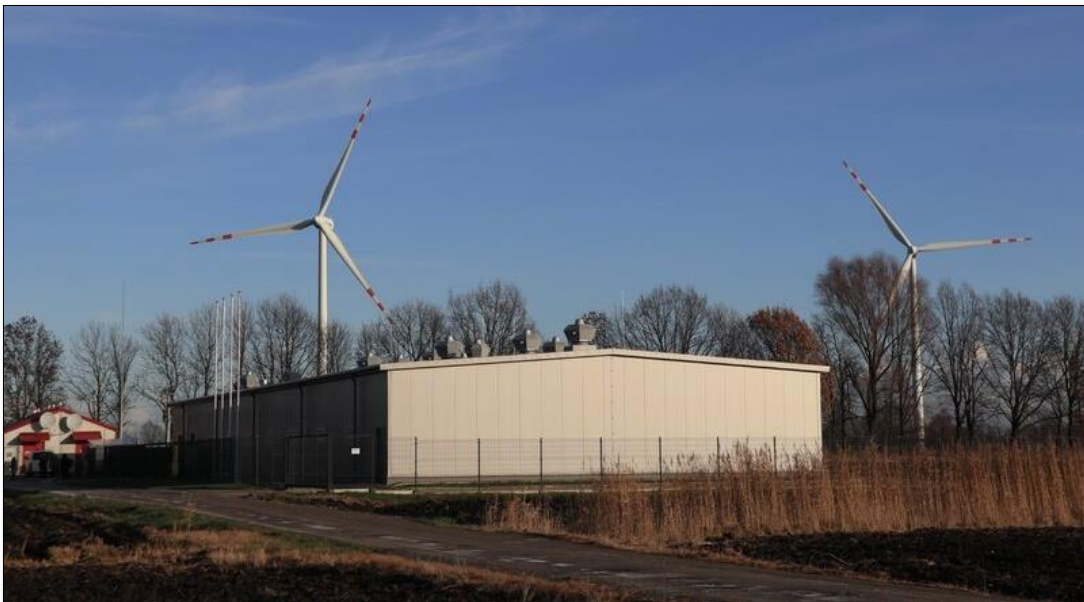
Zdjęcie 2 Budynek hybrydowego magazynu energii BESS przy farmie wiatrowej Bystra
